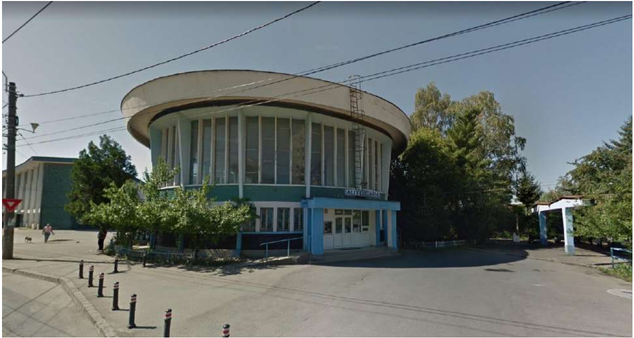
Figură 2-40 - Corp principal Autogara Baia Mare
