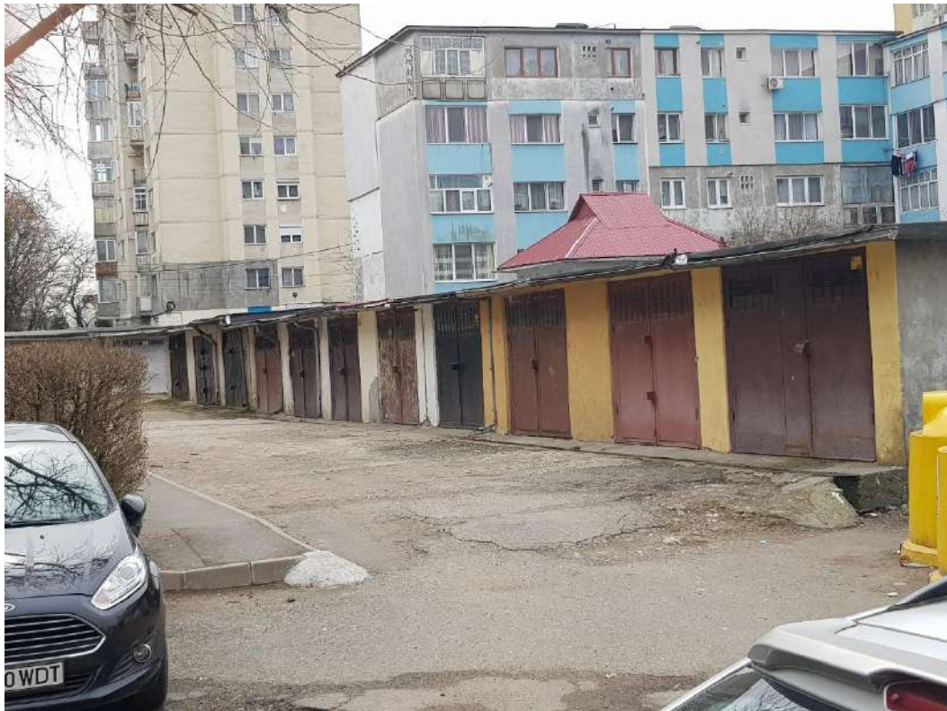
Figură 2-30 - Baterii de garaje Baia Mare – Cartierul Depozit
