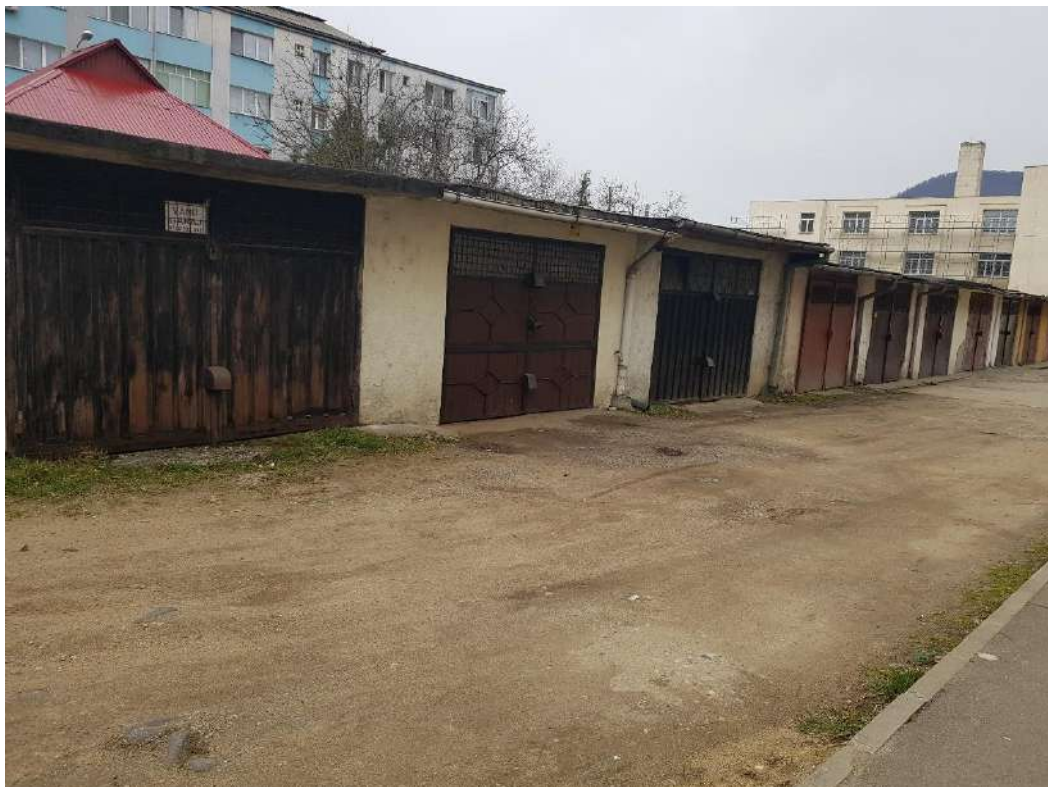
Figură 2-29 - Baterii de garaje Baia Mare – Cartierul Depozit
